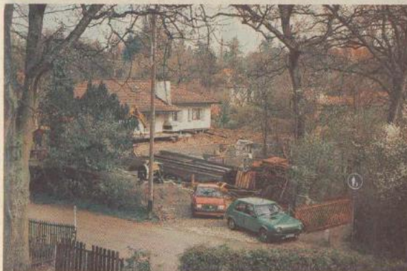
La maison de 240 tonnes a été soulevée à l'aide de vérins hydrauliques. La hauteur de 75 cm atteinte, la maison a été posée sur des rails et déplacée par le principe des galets. (Photo Leverington)
