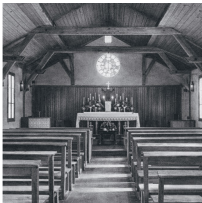
L'intérieur de la nouvelle chapelle avec sa poutraison apparente.
